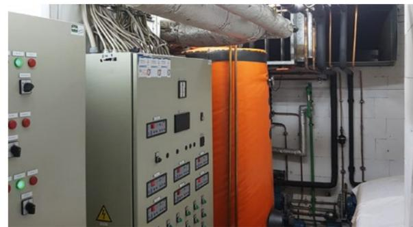
Fleißig und unermüdlich erwärmt das System mit seinem emaillierten 750-l-Speicher und einem doppelwandigen Wärmetauscher direkt Trinkwasser. Installiert von der Kältefirma „Der freundliche Eisbär“ im Jahr 2009 wird somit schon seit über neun Jahren die Abwärme einer Verbundanlage effektiv genutzt. Und dass dies Sinn macht, wird jedem schnell klar!
