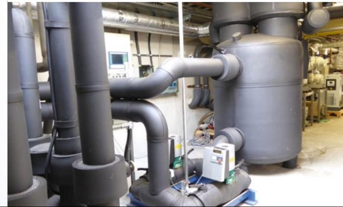
Bei weiteren Umbaumaßnahmen in 2007 wurden zwei DK-Kaltwasserbereiter à 950 Liter mit eingebauten Verdampfern installiert sowie weitere doppelwandige, externe DK-Rohrenhitzer/Kondensatoren. Diese erwärmen Wasser unter anderem für eine Waschanlage, in welcher die Lagerkisten der Schinken gereinigt werden.
